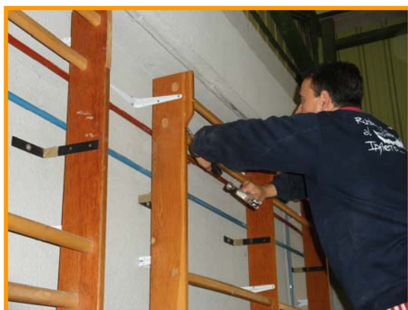
Figura 2.-Colocación de escuadras en la espaldera.
