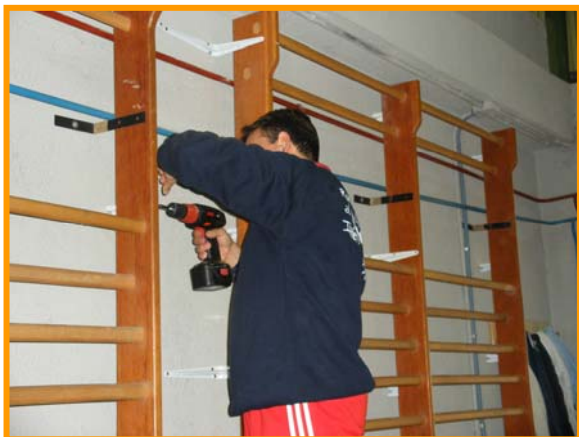
Figura 1.-Fijación de escuadras a espalderas y pared.
